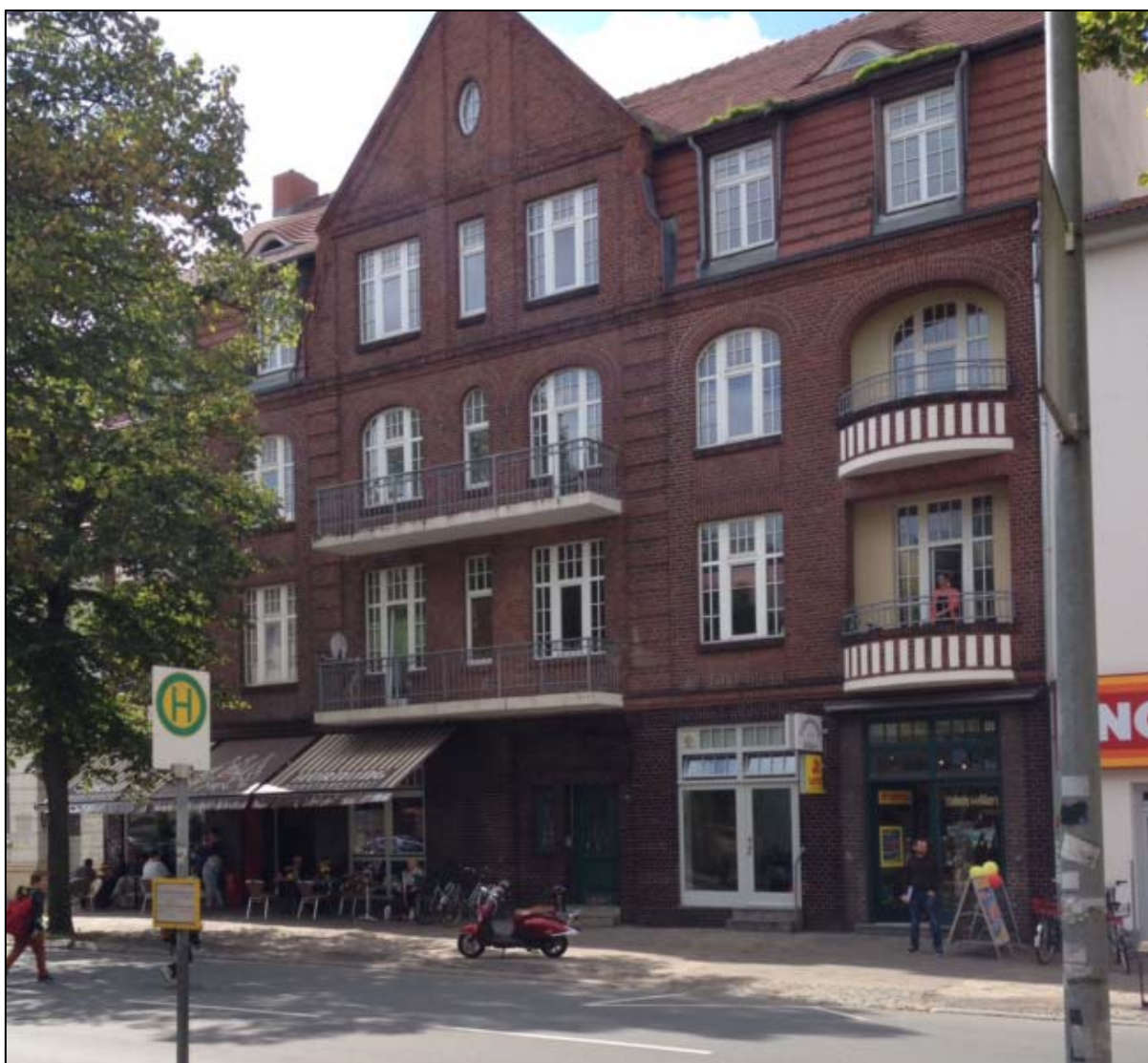
Abb. 4: Wohn- und Geschäftshaus der Eisenbahnstraße 5, September 2018
