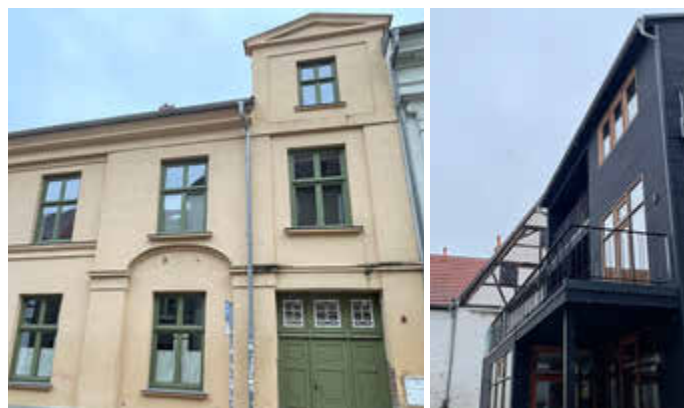
Fotos: Burgstraße 6, li. Straßenansicht, re. neue hofseitige Außenwand
