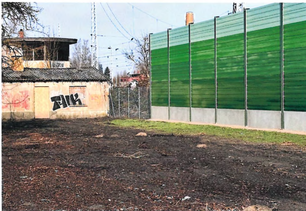
Bild 5: Ende der Lärmschutzwand
