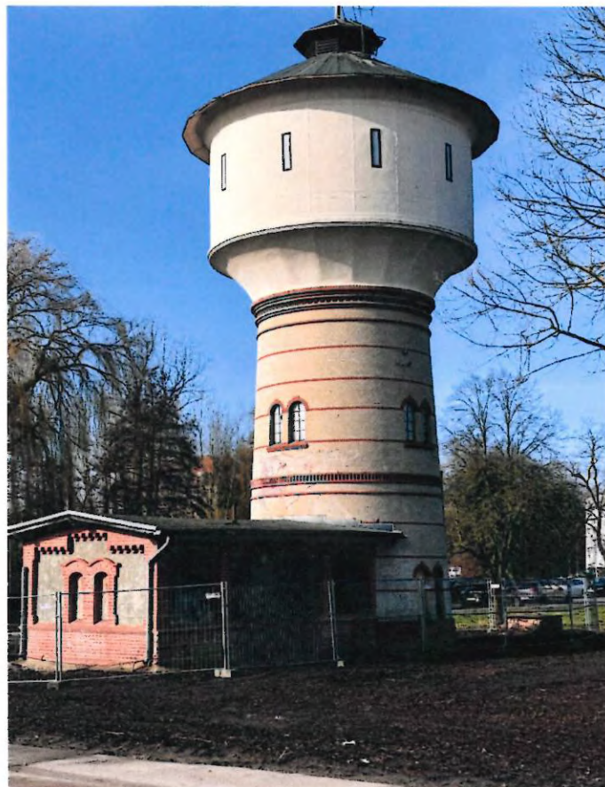
Bild 3: Wasserturm (02/2026) mit Pumpenhaus
