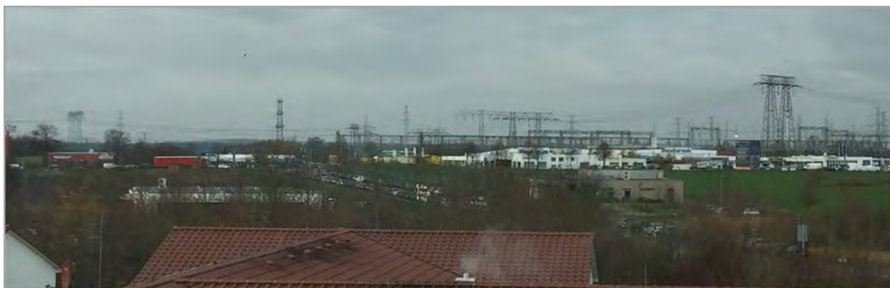
Abbildung 95: Umspannwerk mit vorgelagertem Gewerbegebiet Rostocker Chaussee
