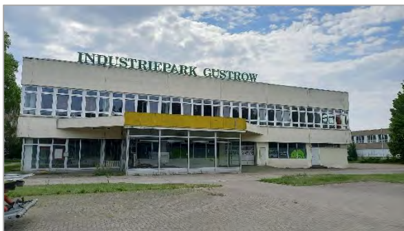
Abbildung 106: Eingangsgebäude Industriepark Güstrow
